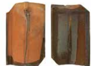
Enkupigt strängpressat tegel med en djup, brun glasyr som har legat på Ungerska ambassadens tak i Stockholm, byggd ca år 1925. Pannorna är ostämplade men är med största sannolikhet svenska. Pris från 260 kr/kvm.
