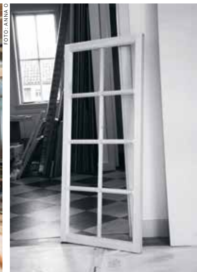
Fönstret ska få rätt beslag, sedan är arbetet färdigt för Håkans del. Återstår för kunden att montera glas i rätt kvalitet, och måla.
